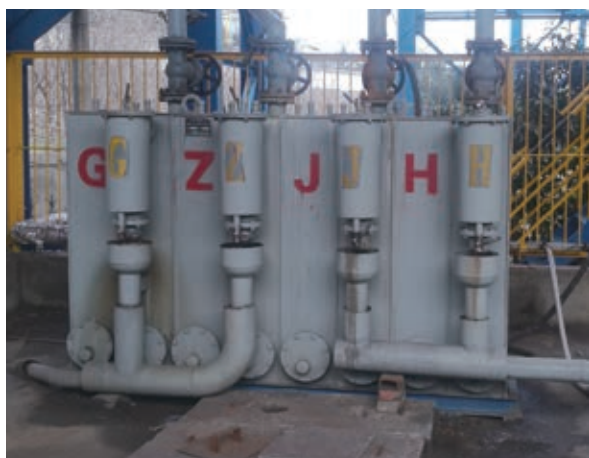
更換成防煤氣洩漏型排水器
